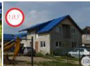
Fig.157, 158. AȘA NU: Vor fi evitate înveltoările în culori stridente din tablă sau din beton, care nu au o durată lungă de viață.
