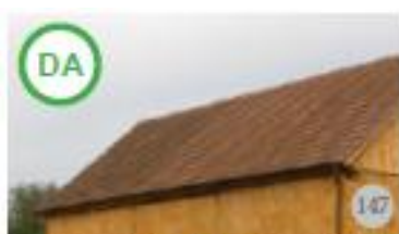
Fig.147, 148. AȘA DA: Țigla ceramică tradițională sau industrială și-au dovedit durabilitatea, chiar de peste 100 de ani în cazul celor produse manual, iar o parte dintre plese sunt inscripționate și au forme unice. Se recomandă completarea învelitorilor ce au țigle lipsă și re folosirea țiglelor în stare bună, chiar și în cazul unor construcții noi sau construcții asupra cărora se întrerup renovări. Se pot pune alternativ țigle noi și vechi. (Drăguș, jud. Brașov)
